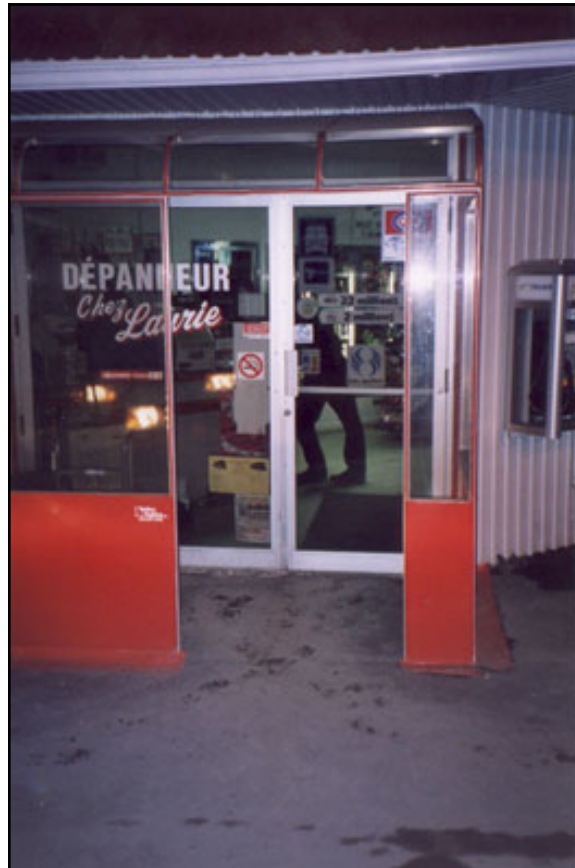
L'abri temporaire réduit l'espace de manœuvre devant la porte.
