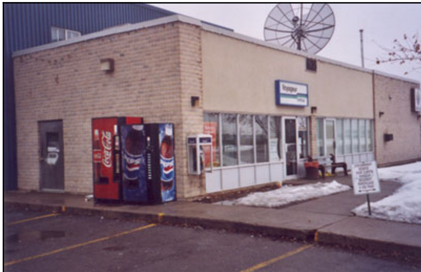
Le trottoir qui mène du stationnement à l'entrée est encombré par 2 machines distributrices.
