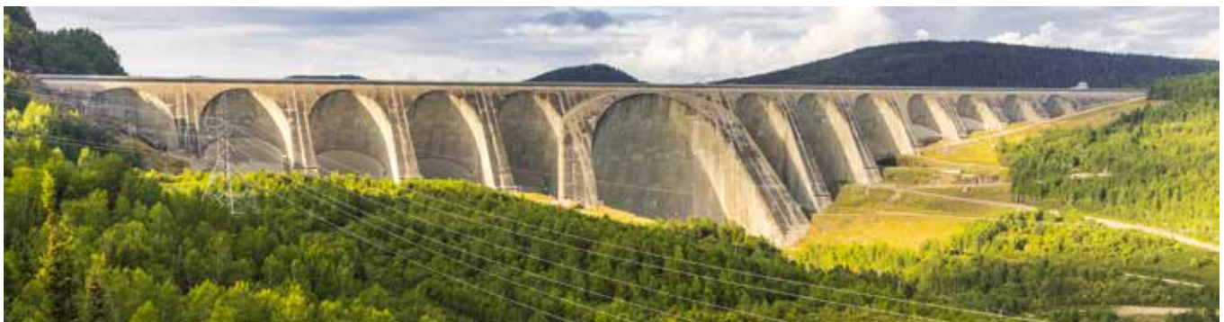
Barrage Daniel-Johnson et la centrale Manic-5 (Hydro-Québec) © GouvQc / M. Dupuis
